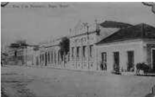
1) Arredores da atual Praça da Estação; 2) Vista da Praça da Igreja Matriz; 3) Rua Flores da Cunha, então 3 de Fevereiro. Princípio do século XX.
