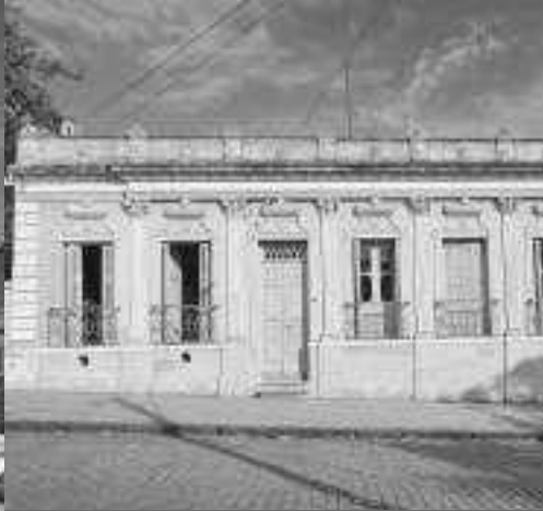
2 Casa Conreiras Rodrigues
